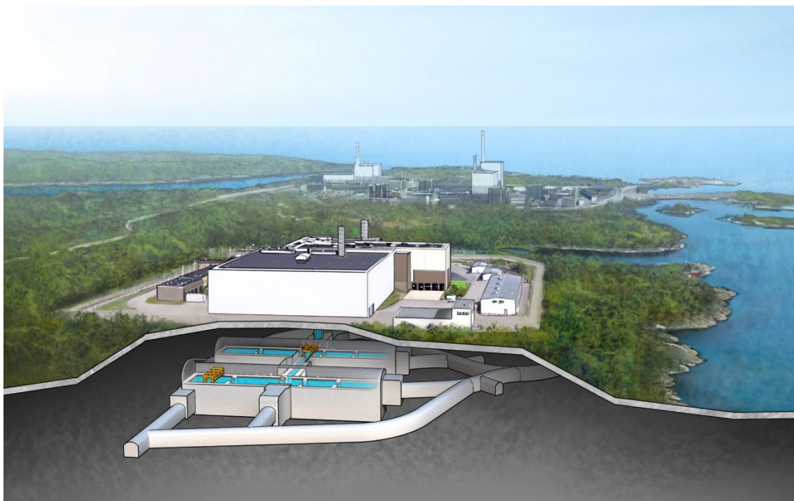
Figur 2-5. Clink med mottagningsdel, lagringsdel i två bergtrum för använt kärnbränsle samt inkapslingsdel.
